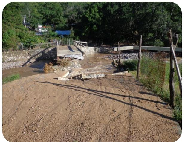
puente del Paso del Ganado **se colapso**
